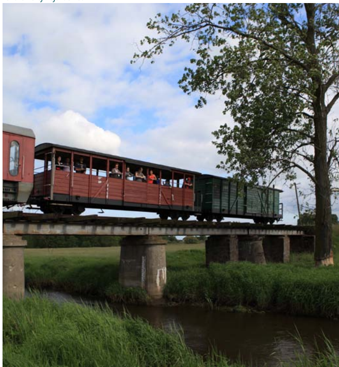
Kaliska Kolej Dojazdowa.
