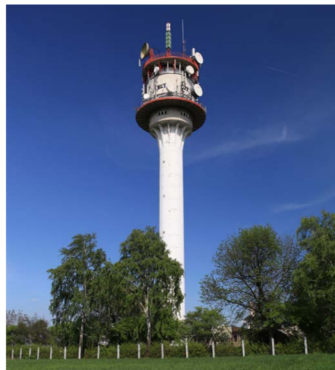
Stacja przekaźnikowa w Chełmcach.
